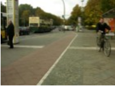
写真7 歩道上に設置された自転車道と逆走自転車
