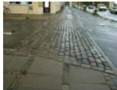
写真14 歩道プラトー
